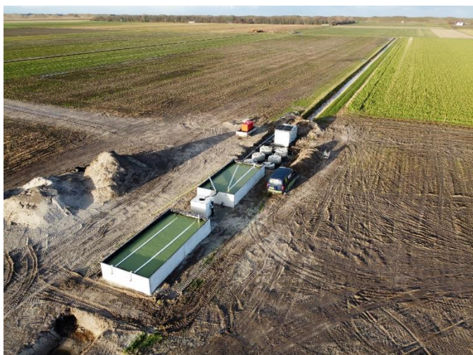
Figuur 15. Aanleg zuivering Postweg afgerond
