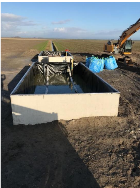
Figuur 14. Aanleg zuivering Hoofdweg afgerond
