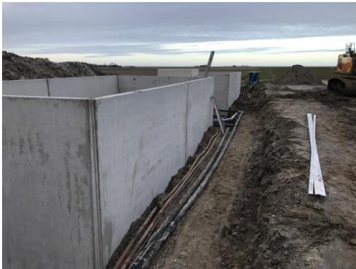
Figuur 12. Betonwanden zuivering
