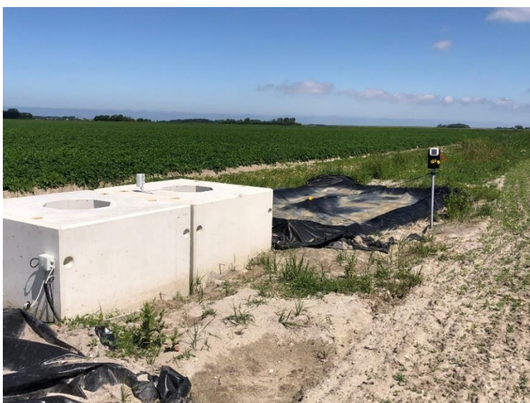
Figuur 1. Pompputten van zowel het zand-als koolfilter
