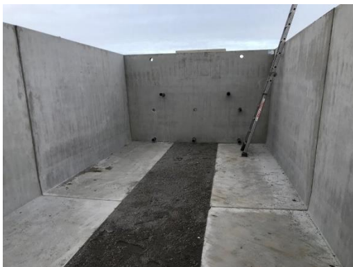
Figuur 11. Betonwanden zuivering
