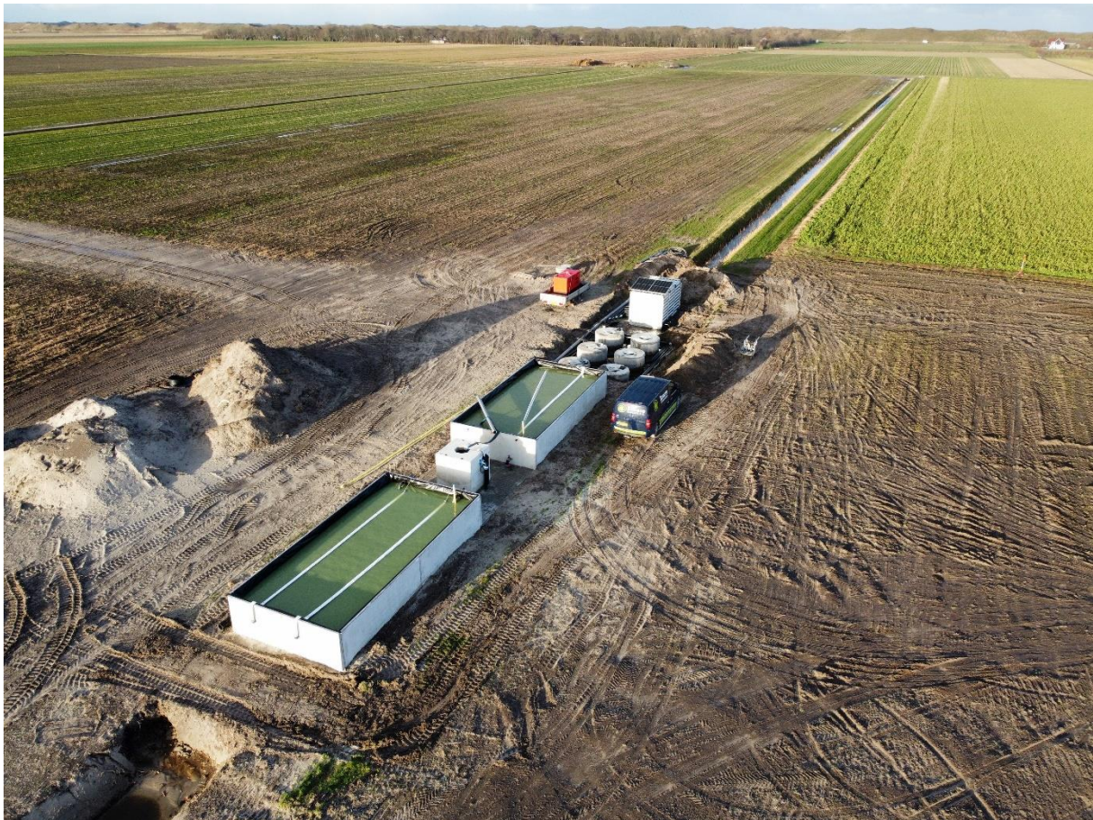
Figuur 14. Aanleg zuivering Postweg afgerond
