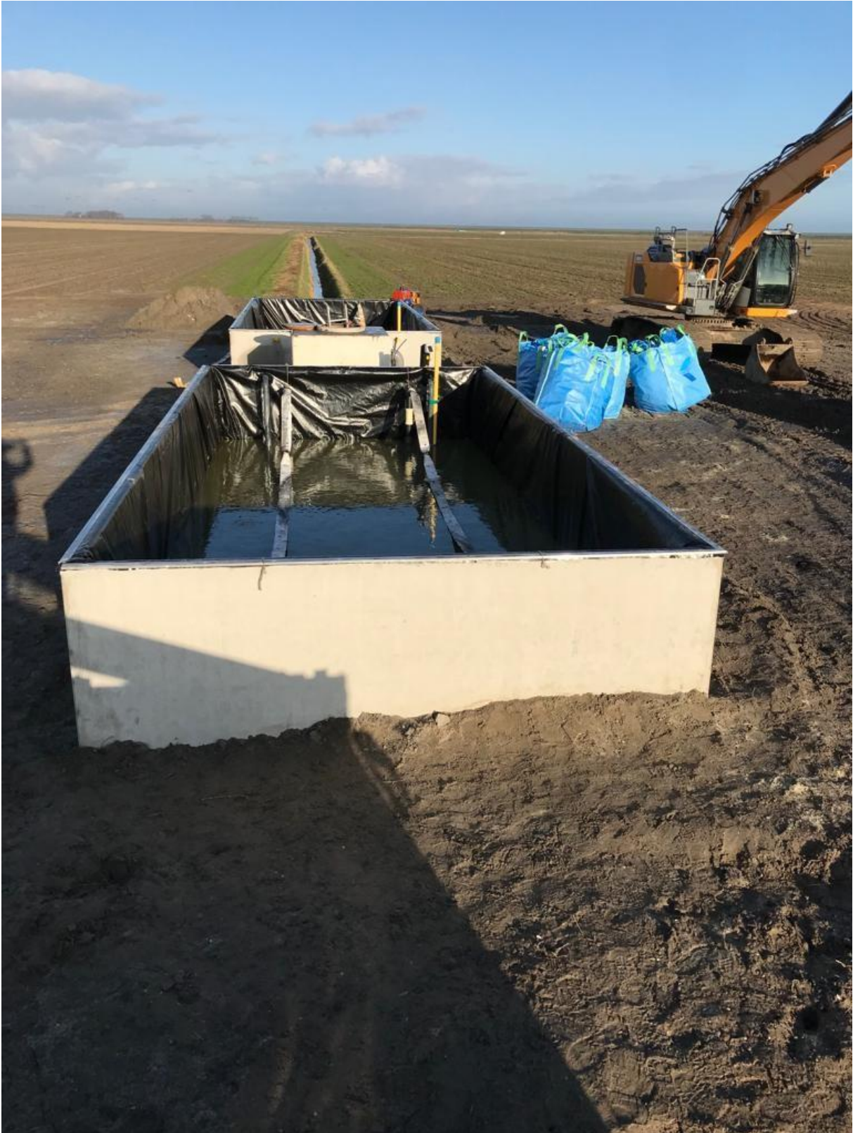
Figuur 13. Aanleg zuivering Hoofdweg afgerond
