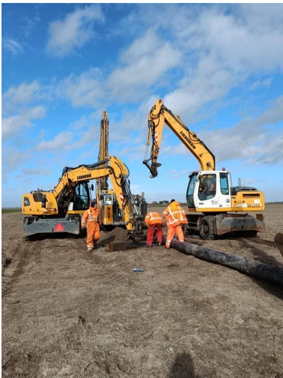
Figuur 2. Aanleg horizontale boring Postweg
