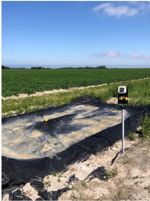
Figuur 11 Bovenaanzicht van het zandfilterbed afgedekt met geotextiel, locatie Hoofdweg
