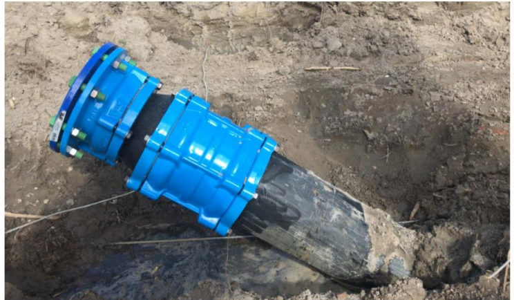
Figuur 5 afsluiting van het uiteinde van de horizontale boring
