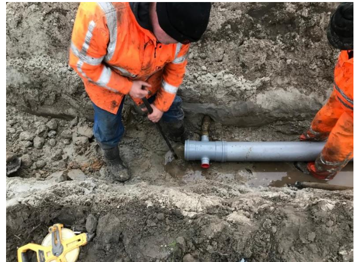
Figuur 7 Aansluiting koppelstuk voor de koppeling tussen velddrainage en verzamelleiding.
