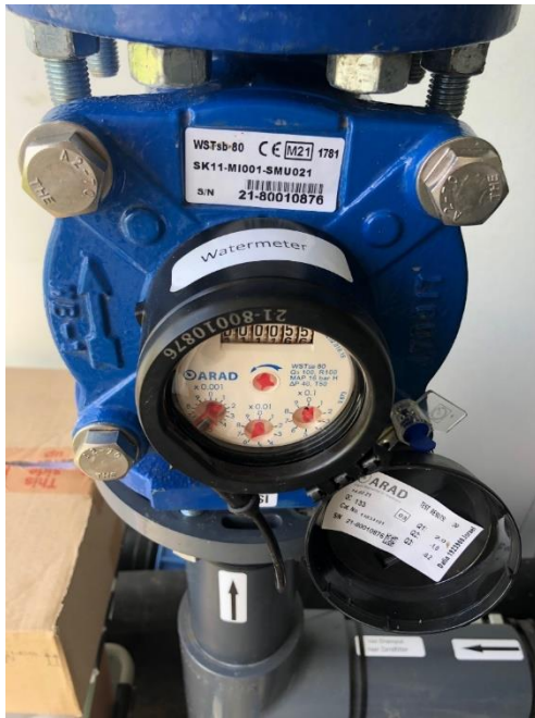
Figuur 16 infiltratiewatermeter peilvak perceel slot
