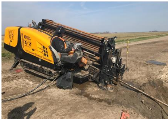
Figuur 23. Uitvoering horizontale proefboring, maart 2021
