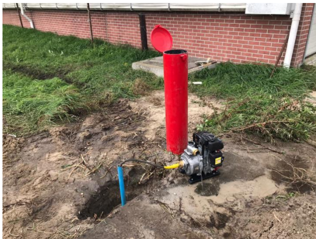
Figuur 11. Plaatsing peilbuizen in aquifer A en aquifer B achter de schuur bij familie Slot aan de Hoofdweg
