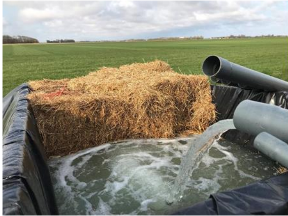
Figuur 27. Strofilter gebruikt bij de afvoer van het onttrekkingswater bij de pompproef
