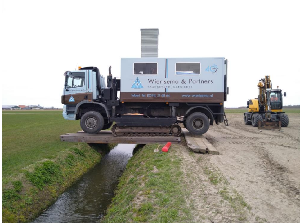
Figuur 25. Het wegdrucken van de diepe peilbuizen vlak langs de horizontale proefboring.
